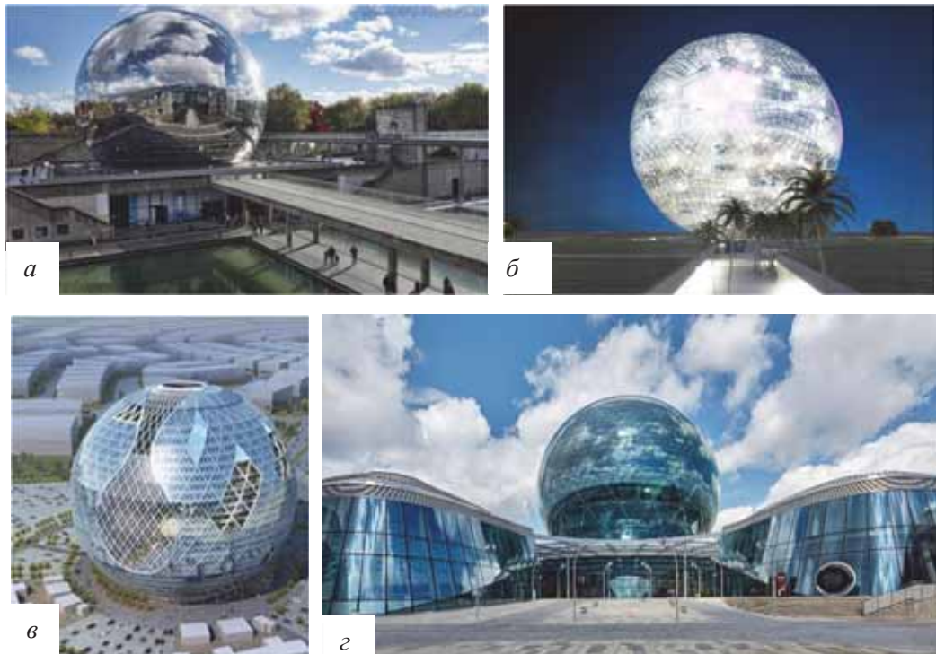
Рис. 5. Архітектурні споруди у формі кулі: а - кінотеатр у Ла Вілет, Париж, 1985, архіт. Адріан Файнзільбер; б - проєкт Музей світового футболу або «Кришталевий м'яч». Катар, архіт. AVP Arhitekti + Sangrad, 2012 р.; в - проєкт Музей еко-глобус. Дубаї, бюро James Law Cybertecture; г - Музей енергії майбутнього. Астана, Казахстан, 2017, архіт. Альберт Шнеєр
