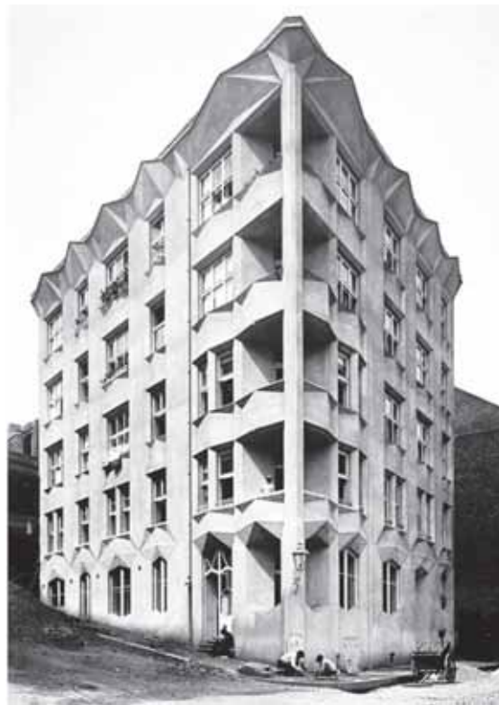
Будинок на Неклановій вулиці, архіт. Йосеф Гогол, 1913–1914
