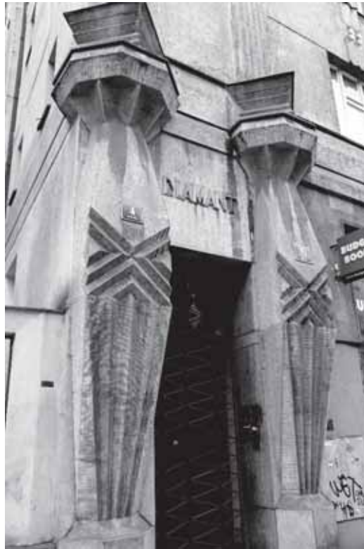
Будинок "Діамант" на вул. Спаленій 4, архіт. Еміль Кралічек, 1912–1913
