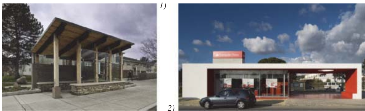
Рис. 7. Зупинки «Функція — Конструкція»: 1) Автобусна зупинка. Китай. м. Гуанчжоу; 2) Автобусна зупинка. Португалія. м. Сетубал. Архітектори антонім Сантас, Петро і Нуно Гаспар
