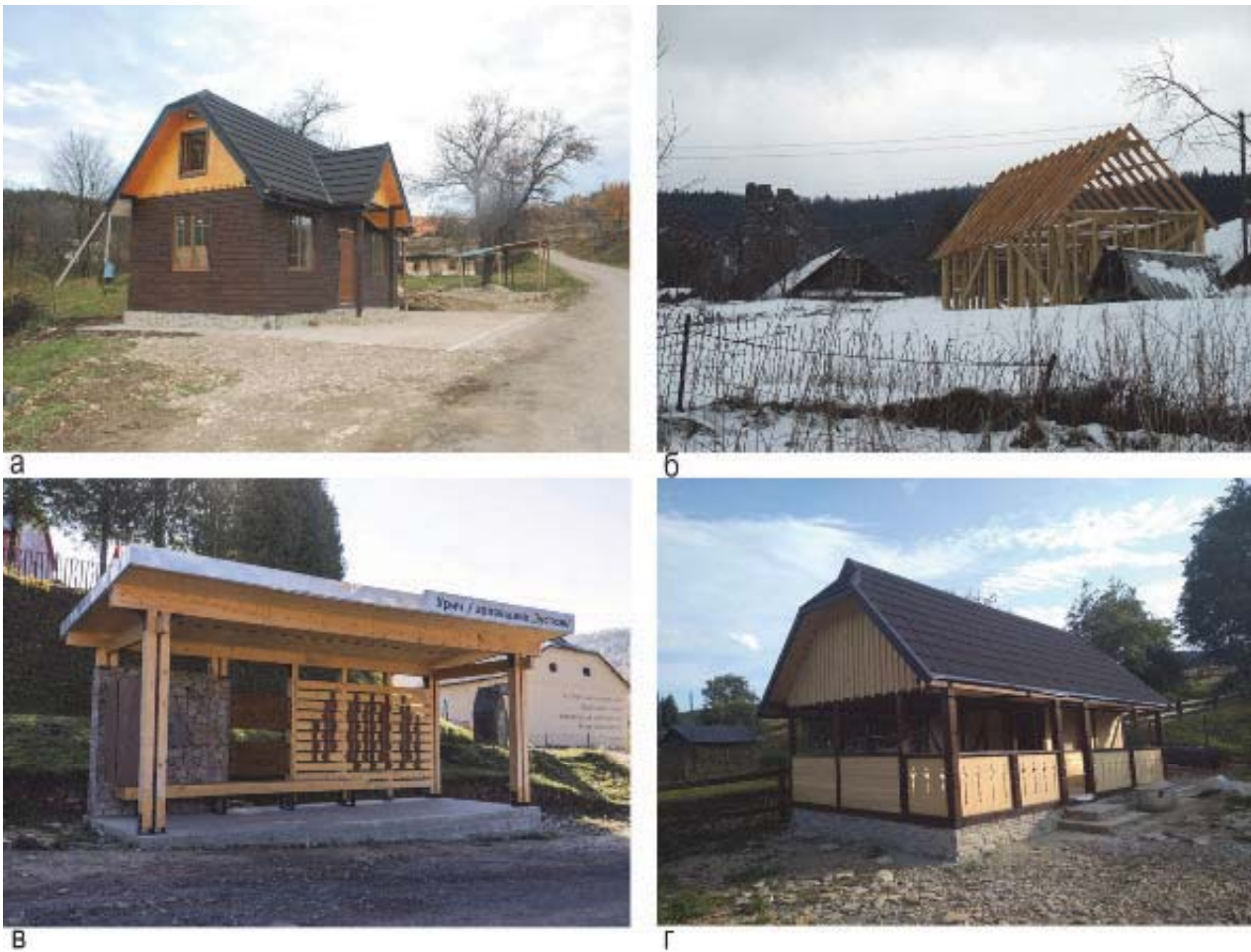
Рис. 14. Нове будівництво в зоні регулювання забудови: а) продуктова крамниця; б) будівництво каркасної господарської споруди; в) зупинка громадського транспорту; г) літній павільйон.
