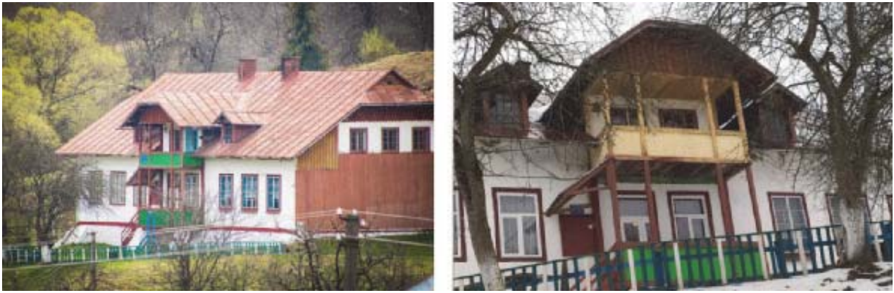
Рис. 9. Оновлення фасаду школи.
