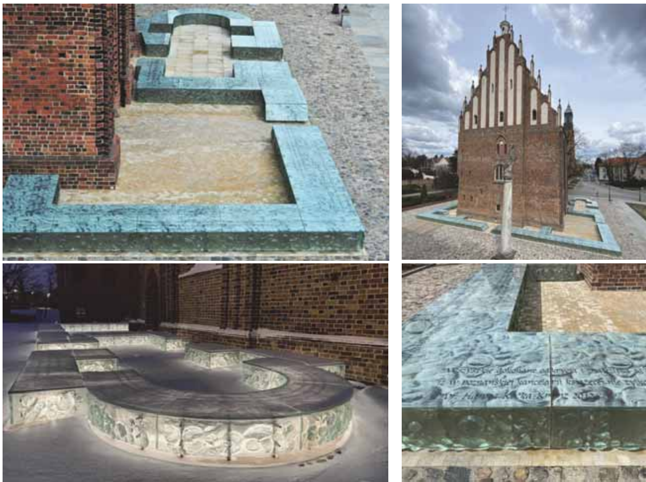
Рис. 4. Ознакування у вигляді об'ємного скляного трасування контуру втраченого палацу Мешка I та його дружини Добрави на Тумському острові в м. Познані (Польща) [12].
