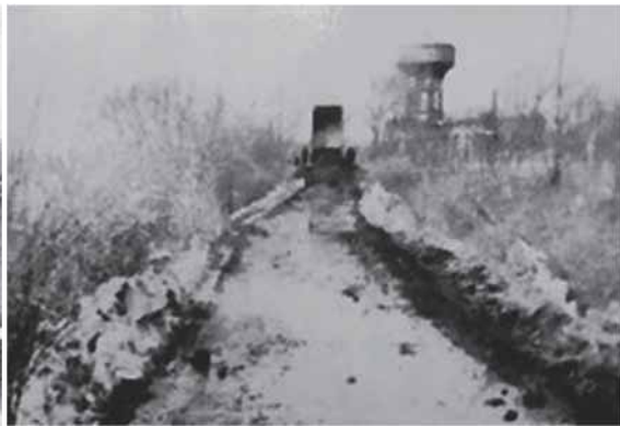
Рис. 15. Будівництво захисної дамби навколо мікрорайону, 1987 р. Джерело: [3]
