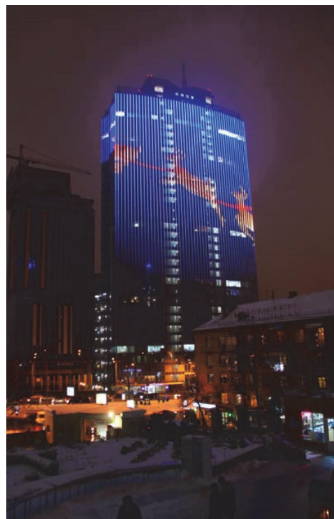
Рис. 3. Медіафасад у ТЦ «Гулівер» ( https://www.lightpoint.com.ua/portfolio/2013_2014/gulliver ).
